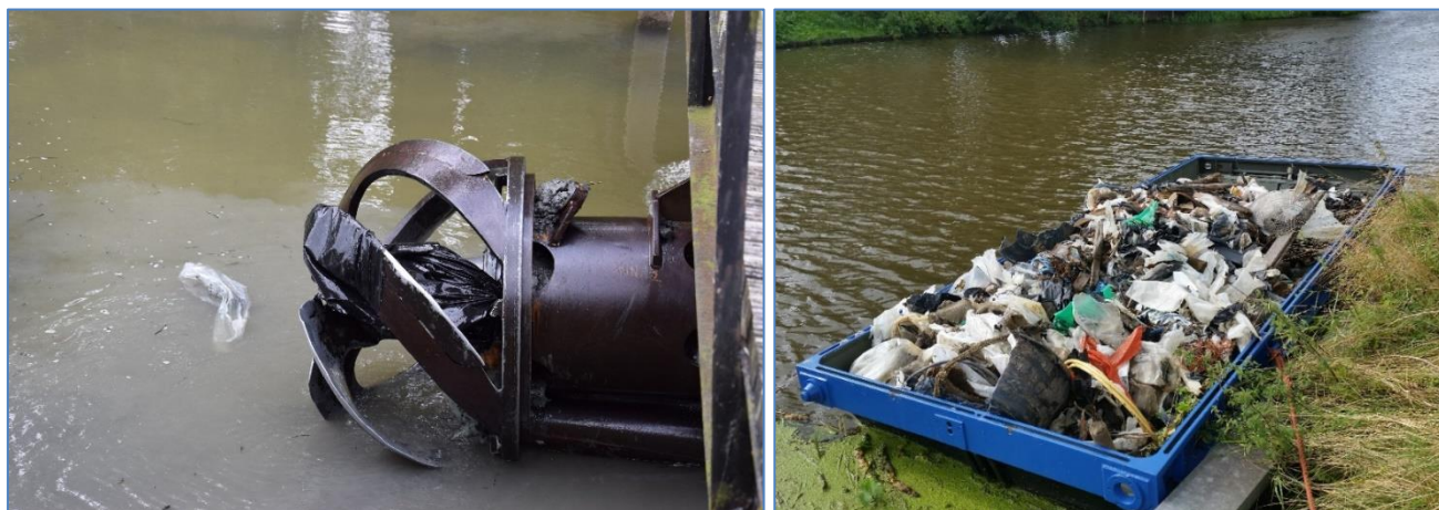
Afbeelding 5.1: plastic in de zuigmond (links) en verwijderd uit de zuigmond en leiding (rechts).
